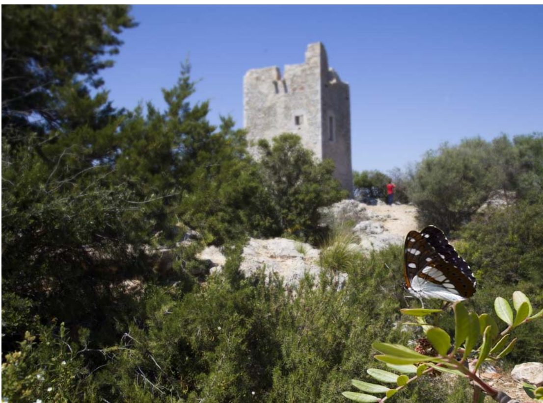
Piana dei Cavalleggeri and Castel Marino's Tower Piana dei Cavalleggeri e Torre di Castel Marino
